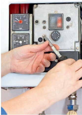
La riparazione di una caldaia
