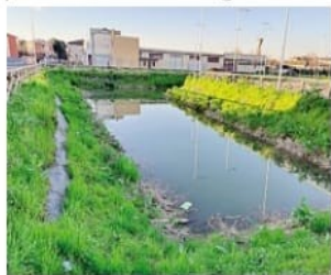
Per il Pd i vasconi vanno chiusi e spostati
