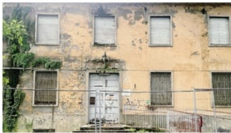
L'ex caserma di via Belloni, in stato di abbandono da decenni Garbarini
