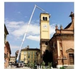
La gru al lavoro sul campanile
